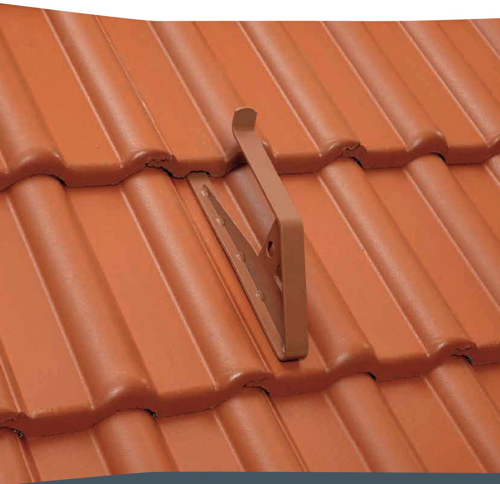
Крюк безопасности — элемент, обеспечивающий закрепление страховочного снаряжения для обслуживания крыши и ремонта кровельного покрытия.
