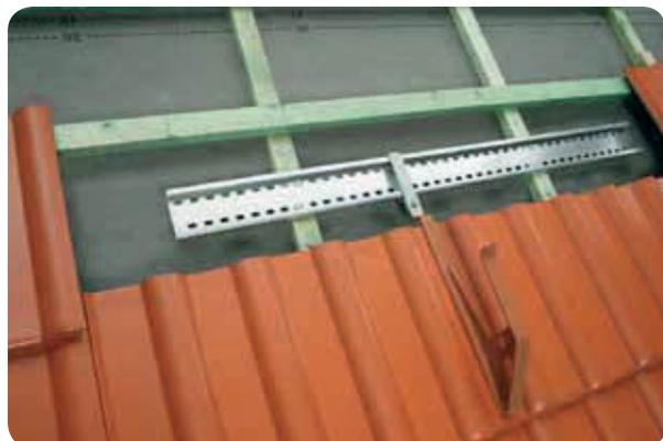
Простая установка между стропилами всегда обеспечивает оптимальное размещение крюка во впадине черепицы. Крюк подходит для всех моделей черепиц в качестве анкерной точки, крепления предохранительного пояса, тросов и для подвешивания лестницы.
